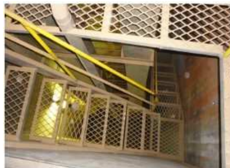
Figura 01 – Escada em “U” com alçapão para içamento de macas
