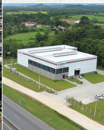
UNIDADE ACESSÓRIOS JOINVILLE / SC
